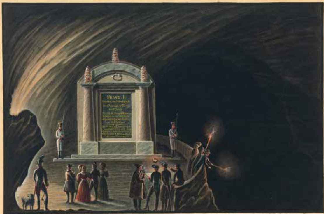
Ansicht des Monumentes an der Natur Brücke. (75 Klüfter vom Eingange.)
